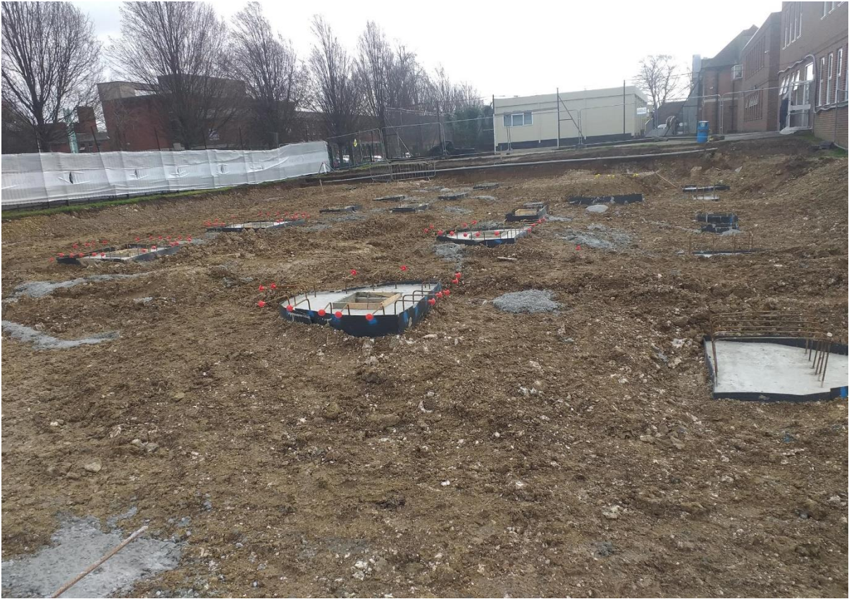
All pile caps poured
